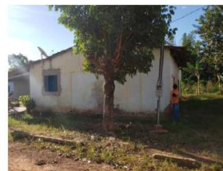
Figura 6. MT_PARANAT_SR_2_CPRM, Moradia em área de planície de inundação do rio Paranatinga, Risco Muito alto a Enchente/Inundação.
