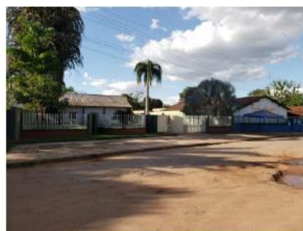
Figura 5. MT_PARANAT_SR_3_CPRM, Casas em área de planície de inundação do rio Paranatinga, Risco muito alto a Enchente/Inundação.
